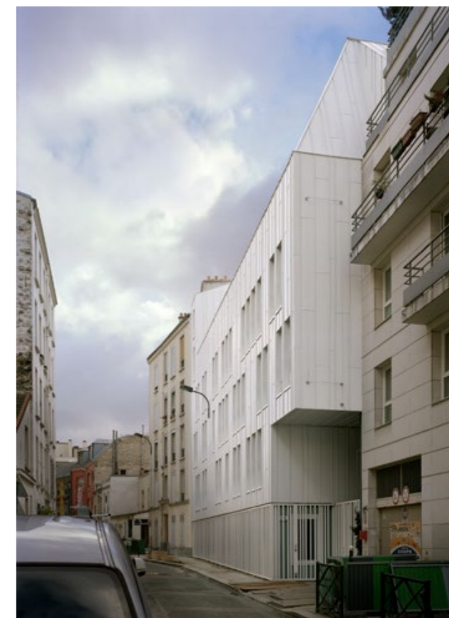
2017 après travaux / Façade rue du Retrait avec porche
