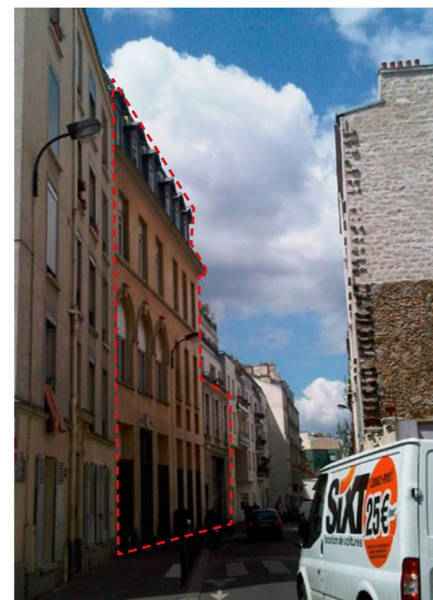
2012 avant travaux / Façade rue du Retrait
