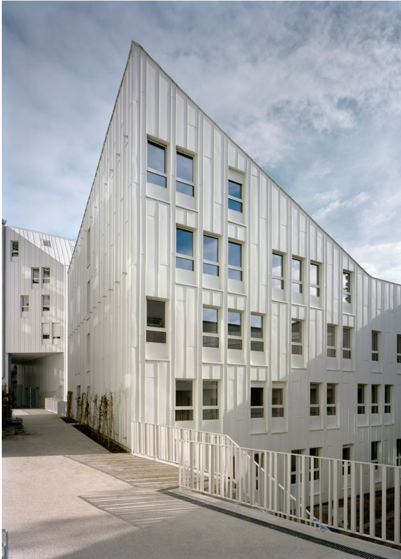
2017, vue de l'intérieur de la parcelle avec la reconstruction de la résidence
