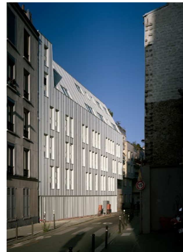
2017 après travaux / Façade rue du Retrait
