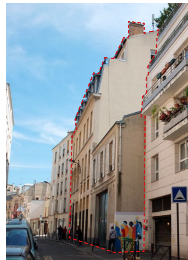
2012 avant travaux / Façade rue du Retrait avec porche
